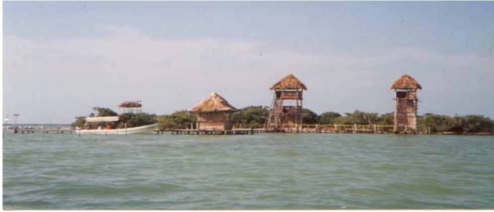
Figura 5. Miradores en Isla Morena de la segunda etapa (PUHAC) y parte de la primera etapa detrás de la lancha).
