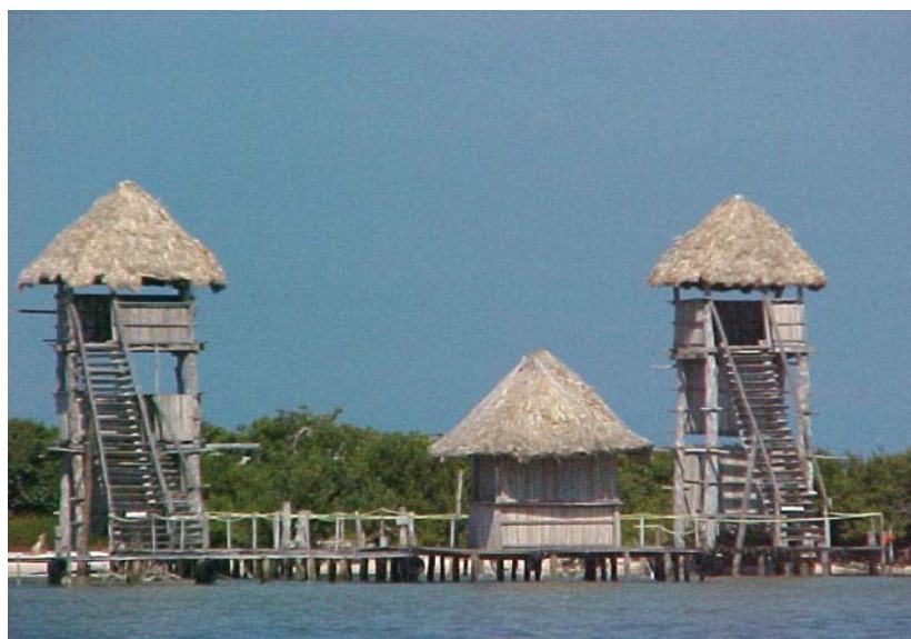
Figura 6. Miradores construidos por PUHAC, 2001.
